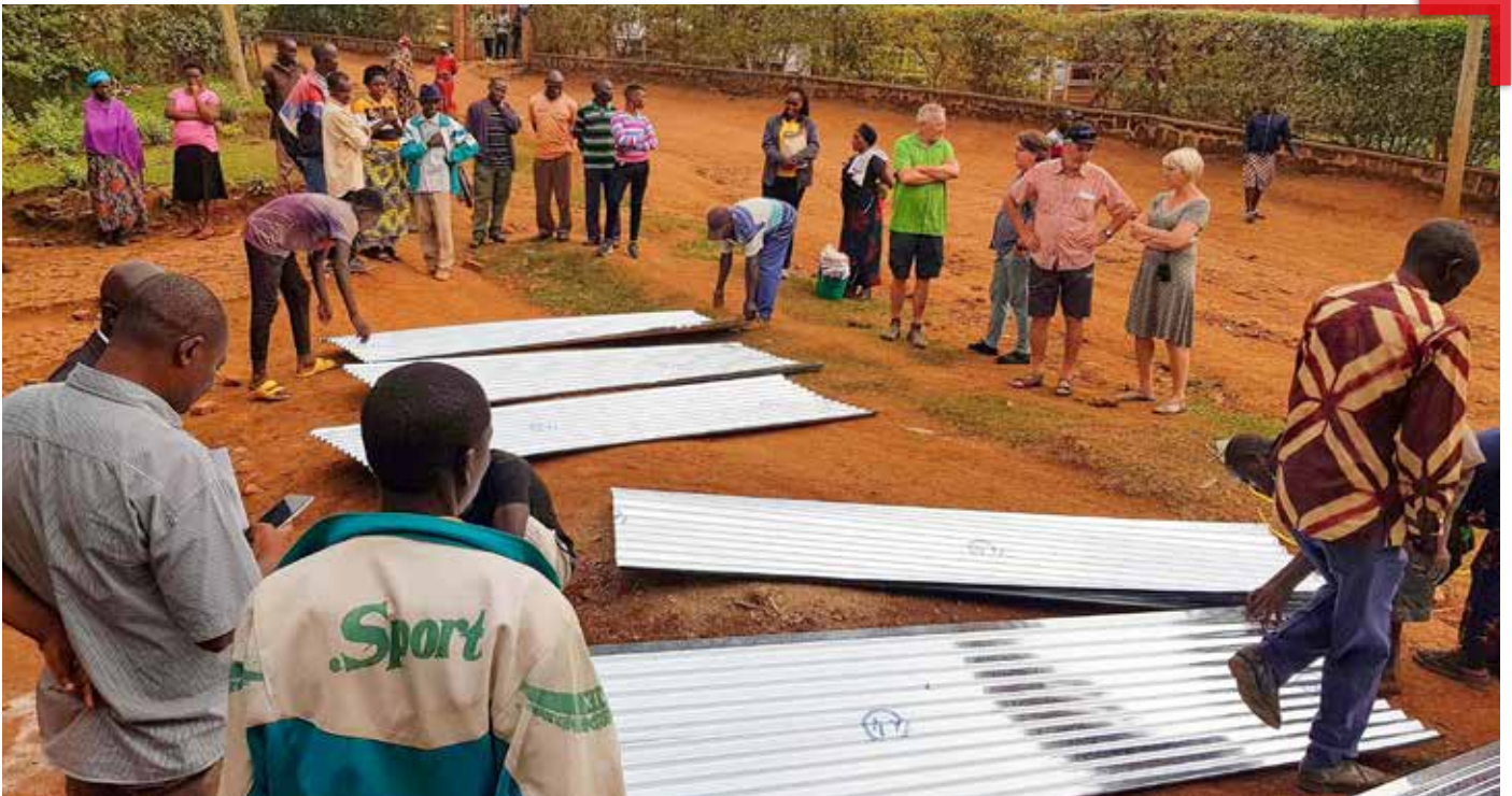
Unterstützung beim Kauf neuer Bleche für dringend notwendige Dachreparaturen.
