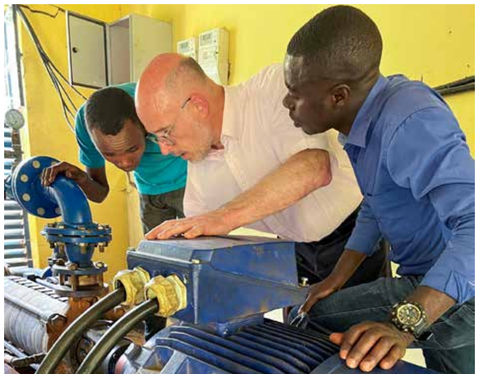
Besichtigung einer Pumpstation zur Wasserversorgung im Sektor Cyinzuzi.
