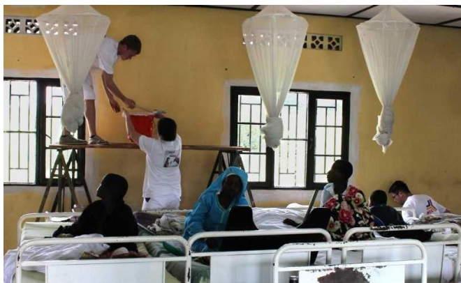
Malergesellen aus Rheinland-Pfalz in voller Aktion: Malerarbeiten im Krankenhaus Gatagara
