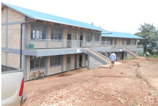
Neubau von zweigeschossigen Schulgebäuden an der Groupe Scolaire Gikonko Catholique
